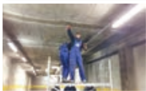
Εφαρμογή ενέματος με ανάπτυξη κρυστάλλων PENETRON® INJECT
