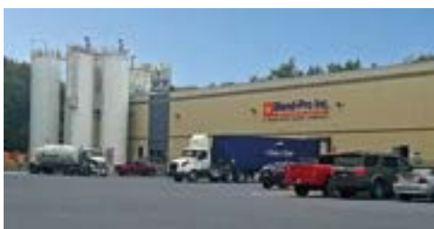
Penetron/Blend-Pro Εργοστάσιο Παραγωγής, Αθήναιου, Πενσυλβάνια, ΗΠΑ
