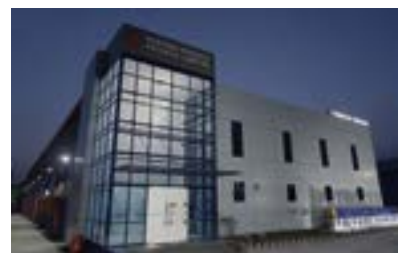
Penetron Εργοστάσιο Παραγωγής, Σάλημ, Ινδία
